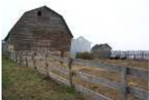
een-machinery and buildings |
