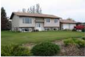
een-machinery and buildings |
